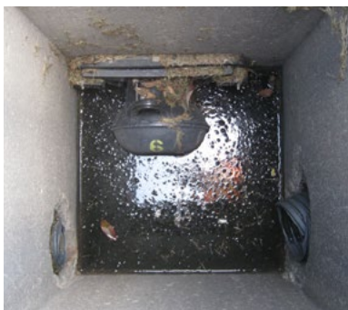
Les unités, dont le débit nominal minimal est de 2 L/s/32 GPM, sont installées sur les entrées existantes du réseau d'égout, afin de limiter le débit et d'empêcher les débris de pénétrer.
